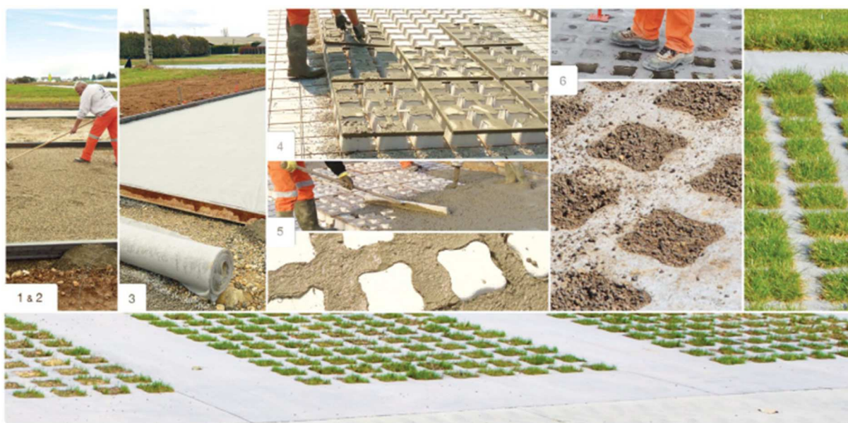
Mode opératoire des dalles bétons engazonnée.
