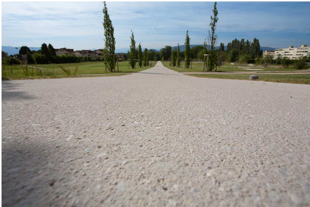
Rendu de l'application d'un béton sablé sur une zone circulaire.
