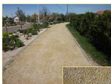
Stabilisé mécaniquement « STABILISÉ CALCAIRE »
